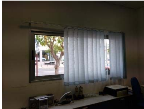
Imagen 3. Carpintería metálica corredera con vidrio monolítico
