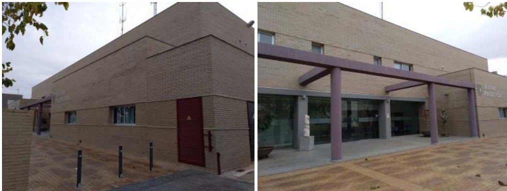
Imagen 2. Fachada de ladrillo cerámico visto
